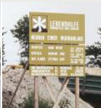
Neubau Wohnheim Von-Dassel-Straße, 1981/82 – das erste selbst geplante, neu gebaute Haus
